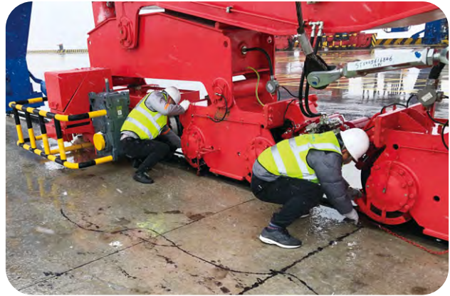
CSP武漢碼頭嚴格執行雪天安全操作規程，在極寒天氣來臨前，對岸橋等機械進行試機排查，加裝鐵楔，保障設備安全運行。
