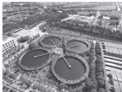
廣東省東莞市北控水務集團水廠內的分佈式光伏發電站
