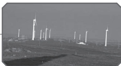
內蒙古自治區包頭市風力發電站
