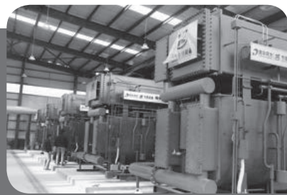
寧夏回族自治區銀川市清潔化燃煤及發電站餘熱能源集中供暖項目
