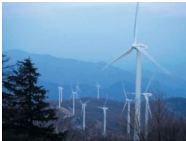
航天龍源（本溪）風力發電有限公司風電場
