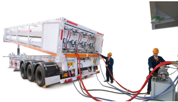
CNG加氣站系統
