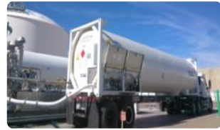
LNG Liquid Factory Loading
