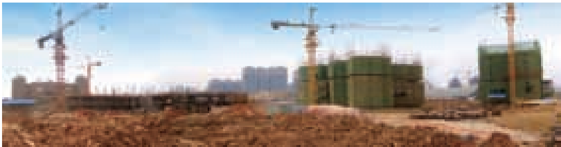
長沙恒大綠洲一期工程現狀實景圖
