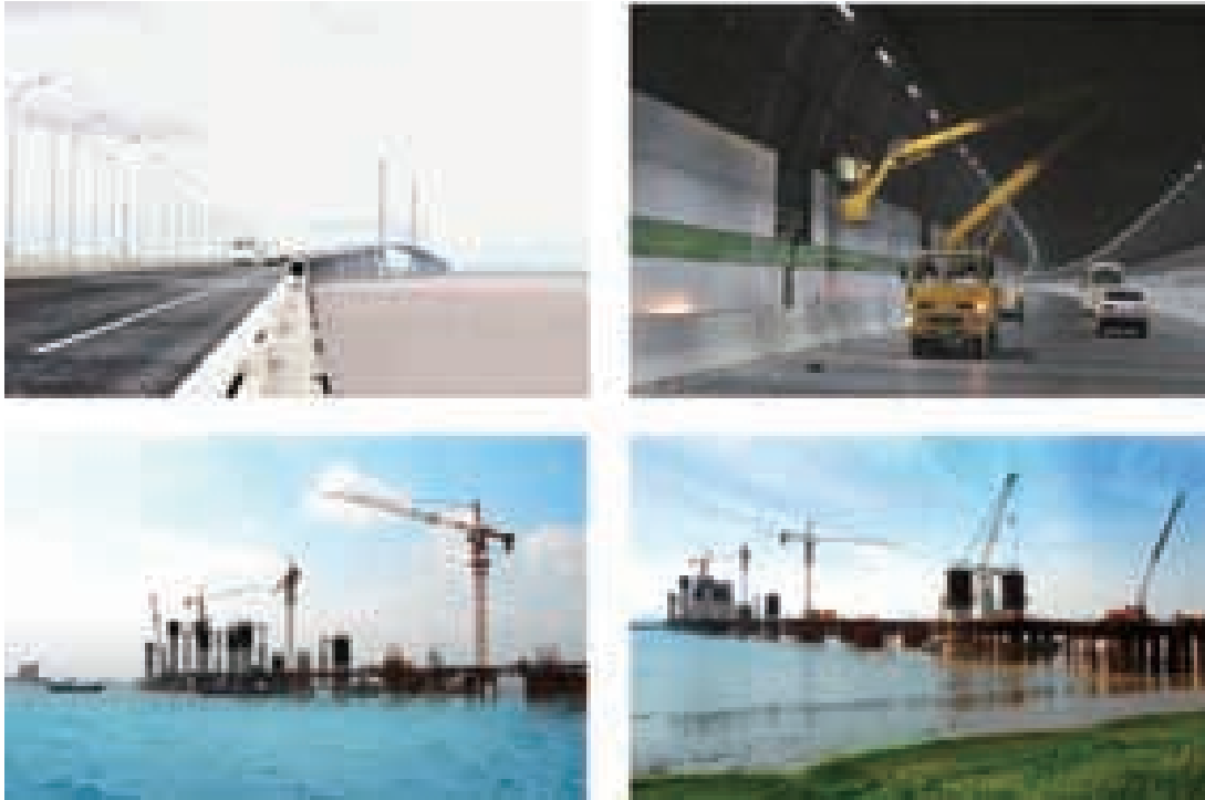
連接啟東—上海的崇啟大橋工程建設實景圖
