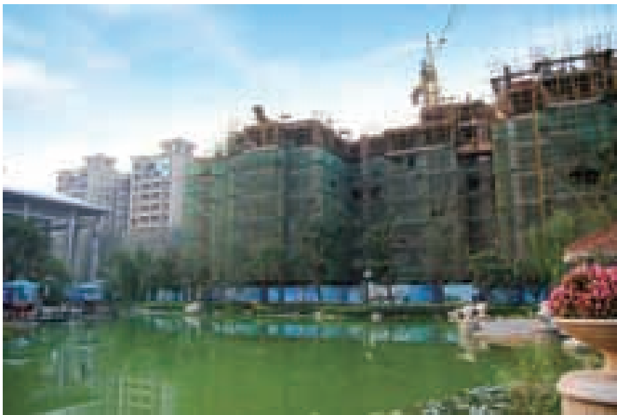
西安恒大綠洲首期工程現狀實況圖
