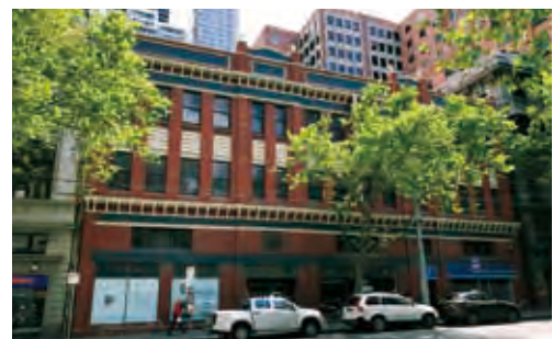
墨爾本 Bourke Street
