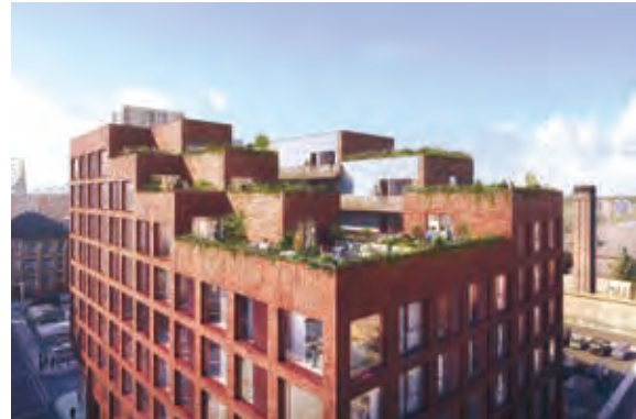
曼徹斯特New Cross Central之屋頂平台
