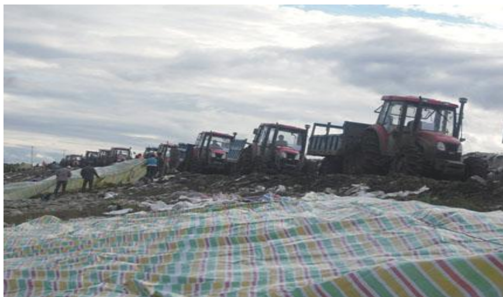
东方红拖拉机在加固大堤现场作业
