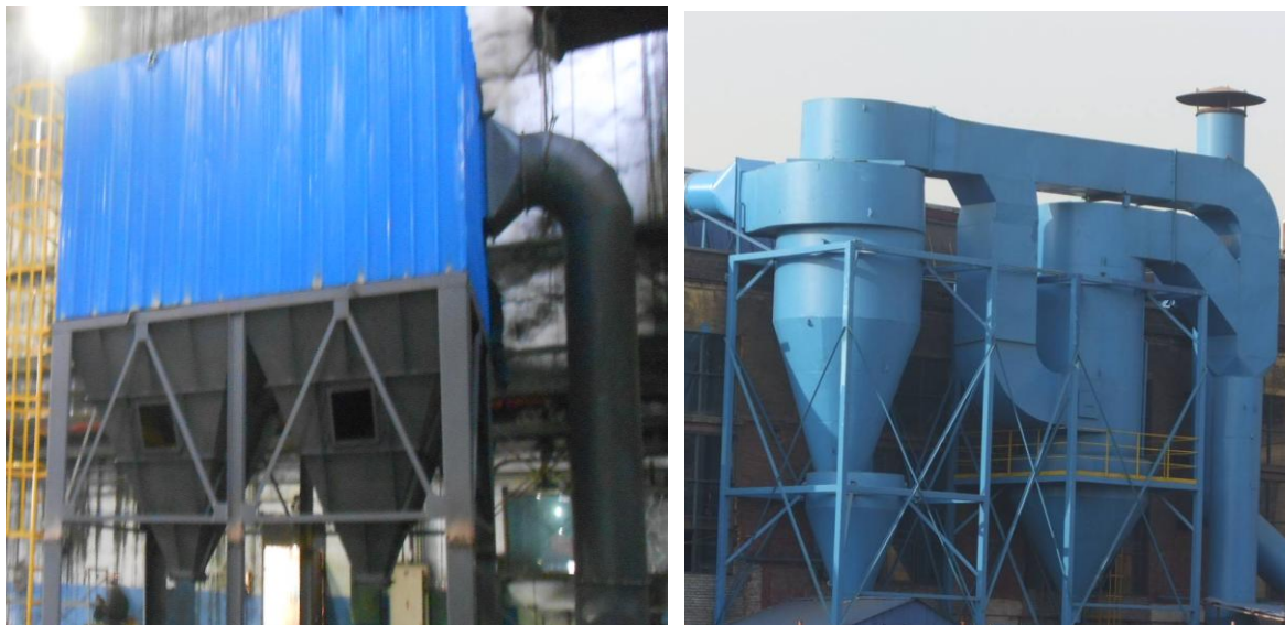
正在施工的环保除尘设备
