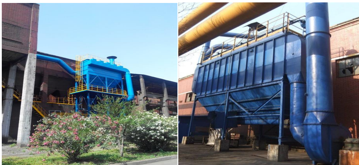
绿色铸造项目除尘实施改造
