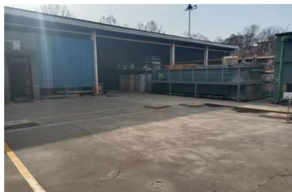
工业废水处理站
