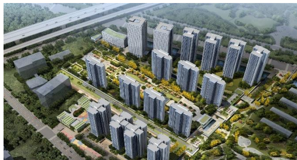
佛山地铁车辆段上盖项目
