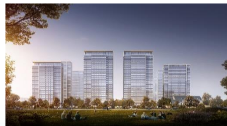
城市更新 石家庄桂语听澜项目
