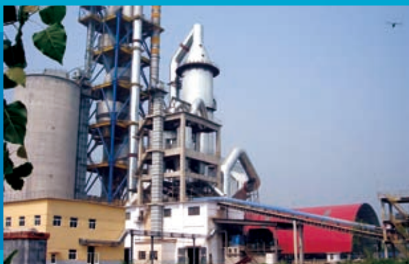
山東聯合王晁水泥有限公司生產綫一角 A snapshot of a production line of Shandong Allied Wangchao Cement Limited
