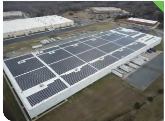
2019年3月，在北卡羅來納州聯想Whitsett工廠安裝太陽能電池板。
