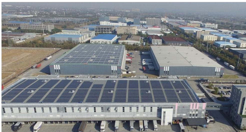
為支持使用可再生能源，順豐房託在旗下的物業頂層安裝太陽能電池板。
