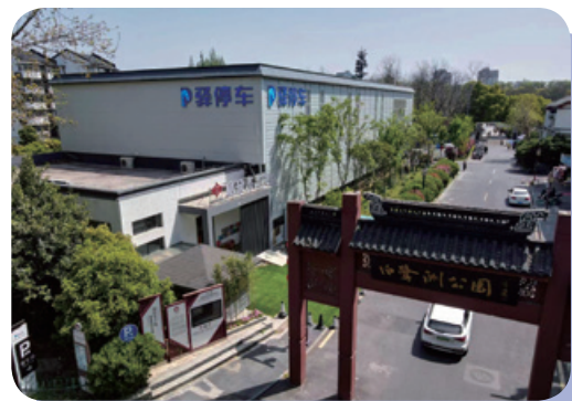
Nanjing Bailuzhou Park Parking Garage Project* 南京白鷺洲公園配套立體停車庫項目
