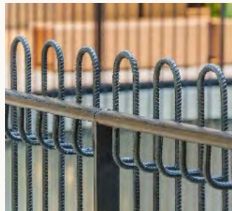
由回收钢筋制成的栏杆
