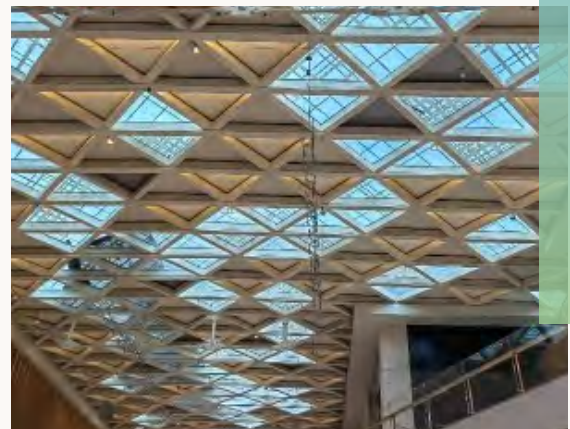
武汉天地壹方南馆、壹方北馆天窗安装外部遮阳
