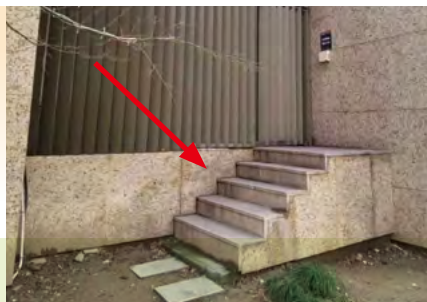
提升地下室的緊急出口
