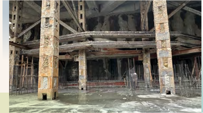
楊浦濱江項目的鋼支撐結構
