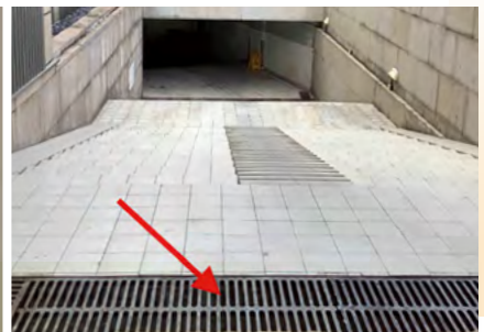
地下室入口的排水溝
