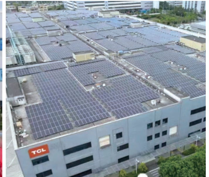
▲ TCL通訊光伏項目竣工
