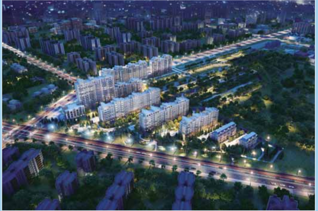
長春天安第一城(四期) (鳥瞰效果圖) Perspective of Changchun Tian An City One (Phase 4) (Aerial View)
