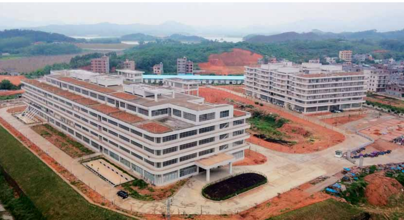
位於中國湖鎮東風村的興建中的廠房及宿舍大樓
