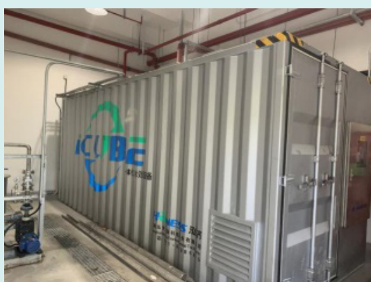
外高橋基地新建的污水處理站
